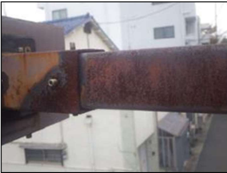
近接目視点検状況
