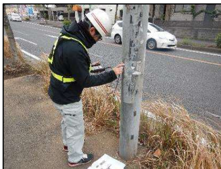
残存板厚調査
