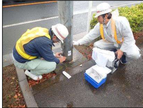
非破壊手法による腐食調査
