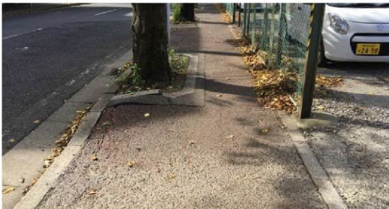
歩道が狭く、樹木の根による凹凸がある
