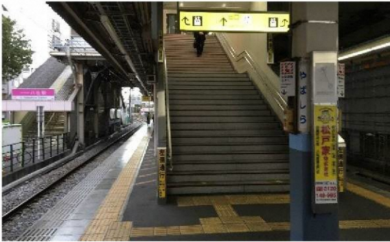
ホームドアが未設置
