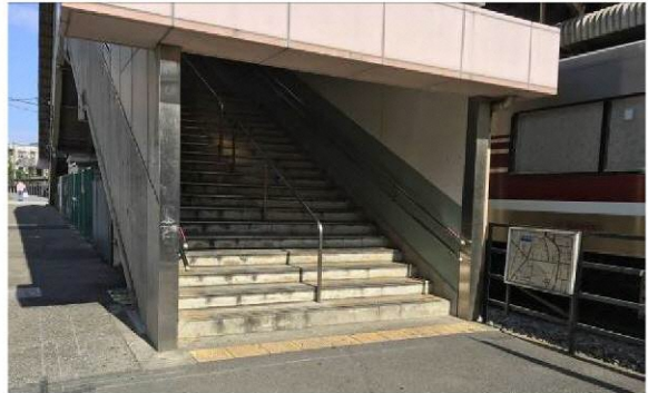
エレベーターが設置されていない
