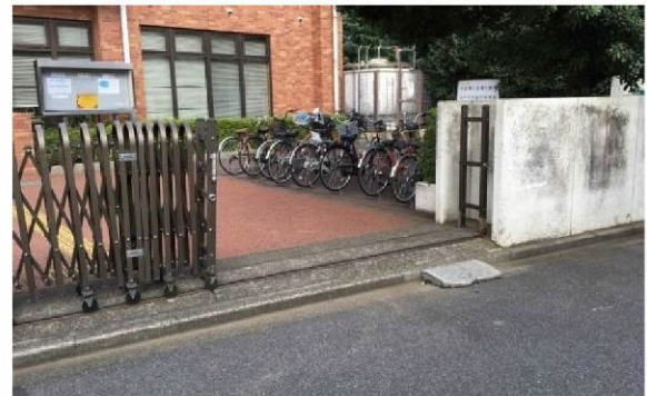
敷地出入口の段差
