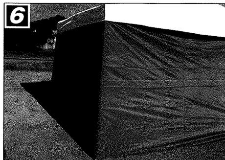
6 すべての横幕を連結した後、天幕を戻し天幕のマジックテープと横幕、(フレーム柱部)のマジックテープとをしっかりと貼り付けて完成です。
