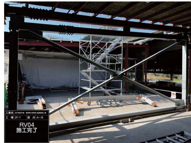
補強フレーム写真抜粋
