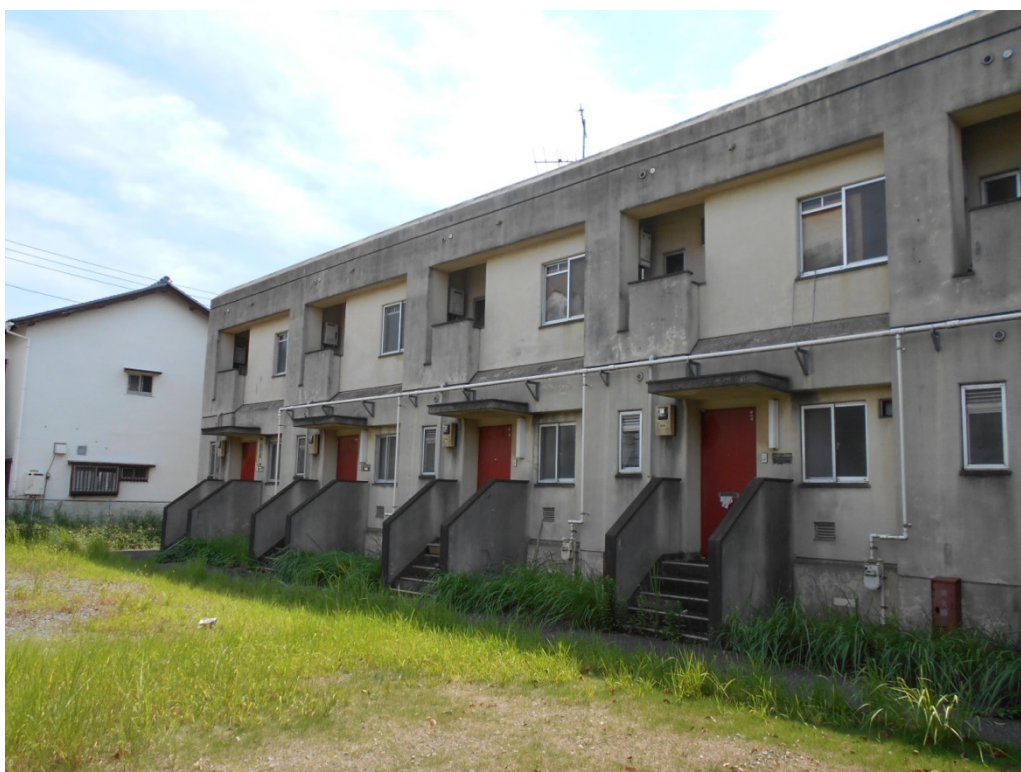
【建物外観（北側建物の玄関側②）】
