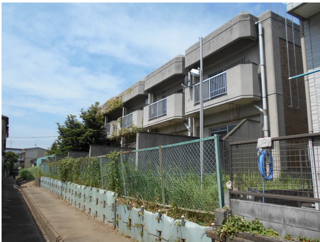
【建物外観（南側建物のベランダ側）】
