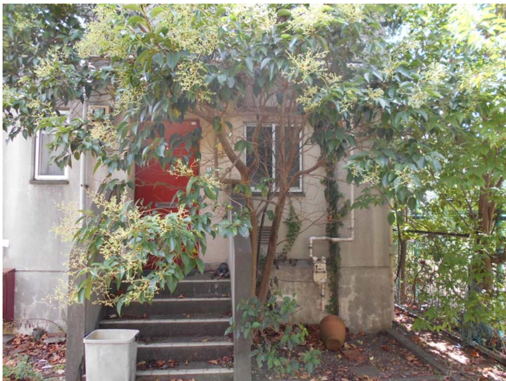
【北側建物の玄関側】
