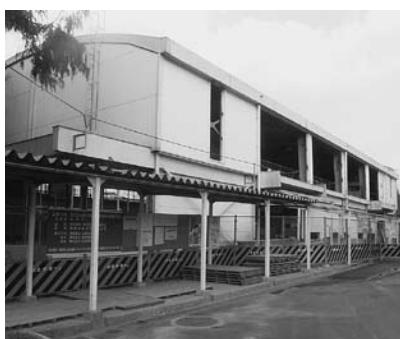
耐震改修工事中の屋内体育館(小金南中学校)
